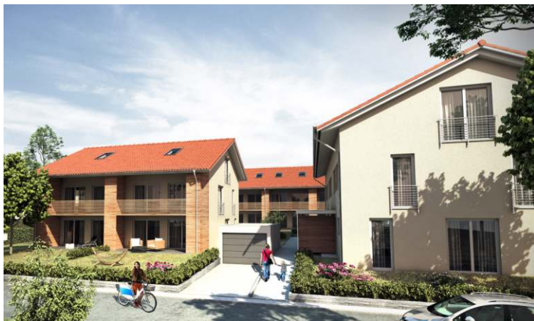
Grünwangen – Untersigginger Straße | Fertigstellung 2021
