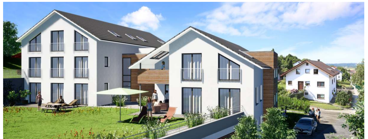
Bermatingen – Autenweiler Straße | Fertigstellung 2021
