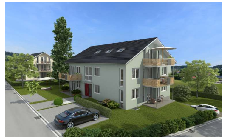
Mühlhofen – In der Dohle 23 | Fertigstellung 2014
